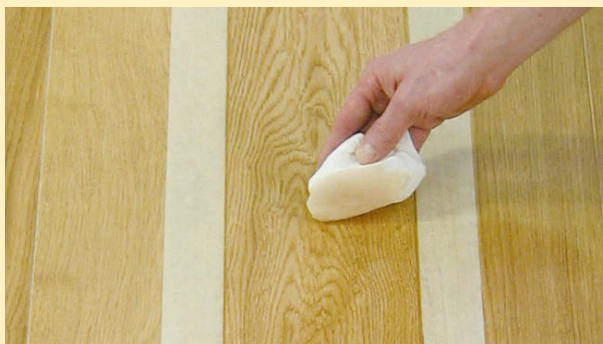
Po uschnutí naneste 2. vrstvu velmi tence bavlněným hadříkem.
