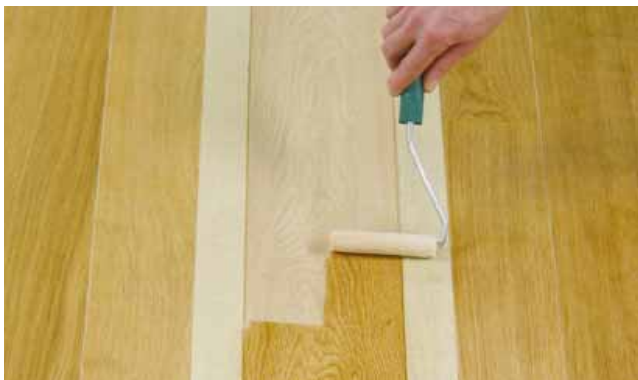
11) Nanesení Osmo Tvrdého voskového oleje v tenké vrstvě válečkem z mikrovláken
