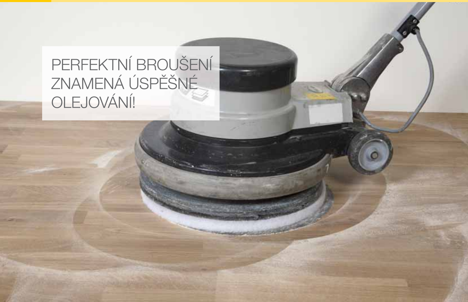
Broušení dřevěné podlahy jednokotoučovým strojem
