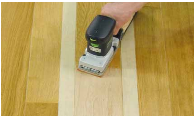
10) Rovnoměrné obroušení poškozeného povrchu
