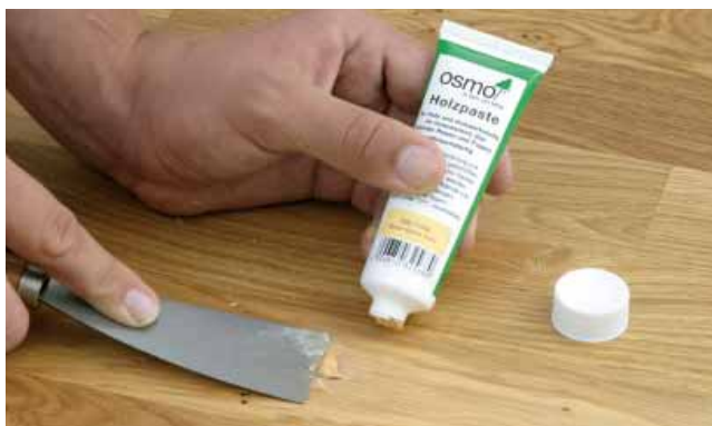
3) Malé trhliny a díry v povrchu dřeva opravit Osmou pastou na dřevo
