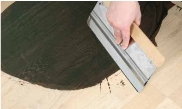
6) Rozdělení Osmo Barevného oleje stěrkou
