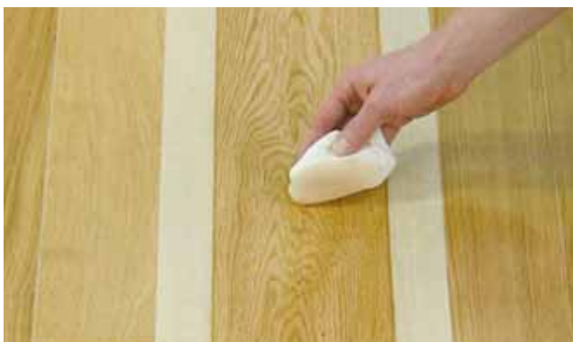
12) Nanesení Osmo Tvrdého voskového oleje v tenké vrstvě po uschnutí prvního nánosu
